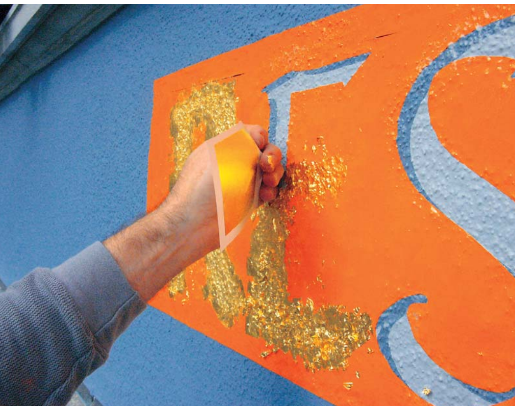
Beim Vergolden der Fassadenbeschriftung. (Foto: Beat Soller)
