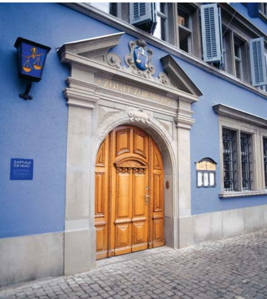
Das Eingangsportal nach der Sanierung 2004. (Foto: Beat Soller)
